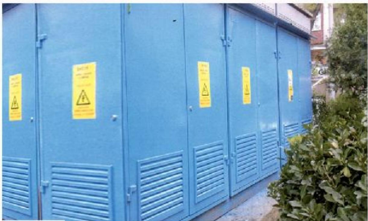
*Trafo merkezi kapı sistemi hafif 2 mm. galvanizli sacdan monoblok saca format verilerek imal edilip, menteşe sistemi sifore pikten özel olarak tasarlanmış menteşe üzerindeki yükü azaltan bir kapı modelimizdir.*
